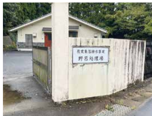
農業集落排水事業 野呂処理場
