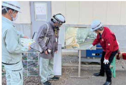
公共下水道 南部浄化センター
